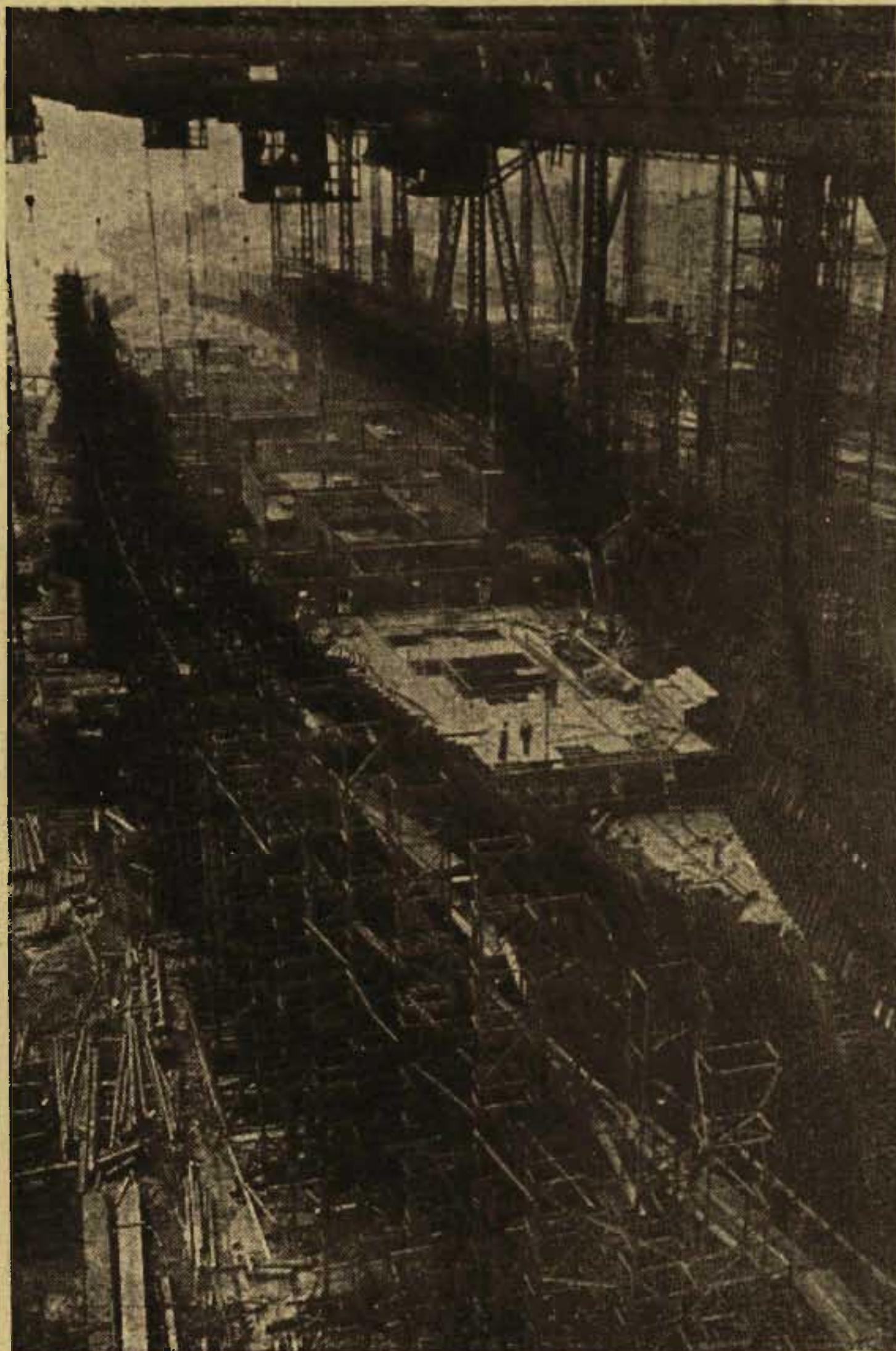
Construcția unui gigantic vapor transatlantic : primele faze ale construcției pe cală, în șantier
