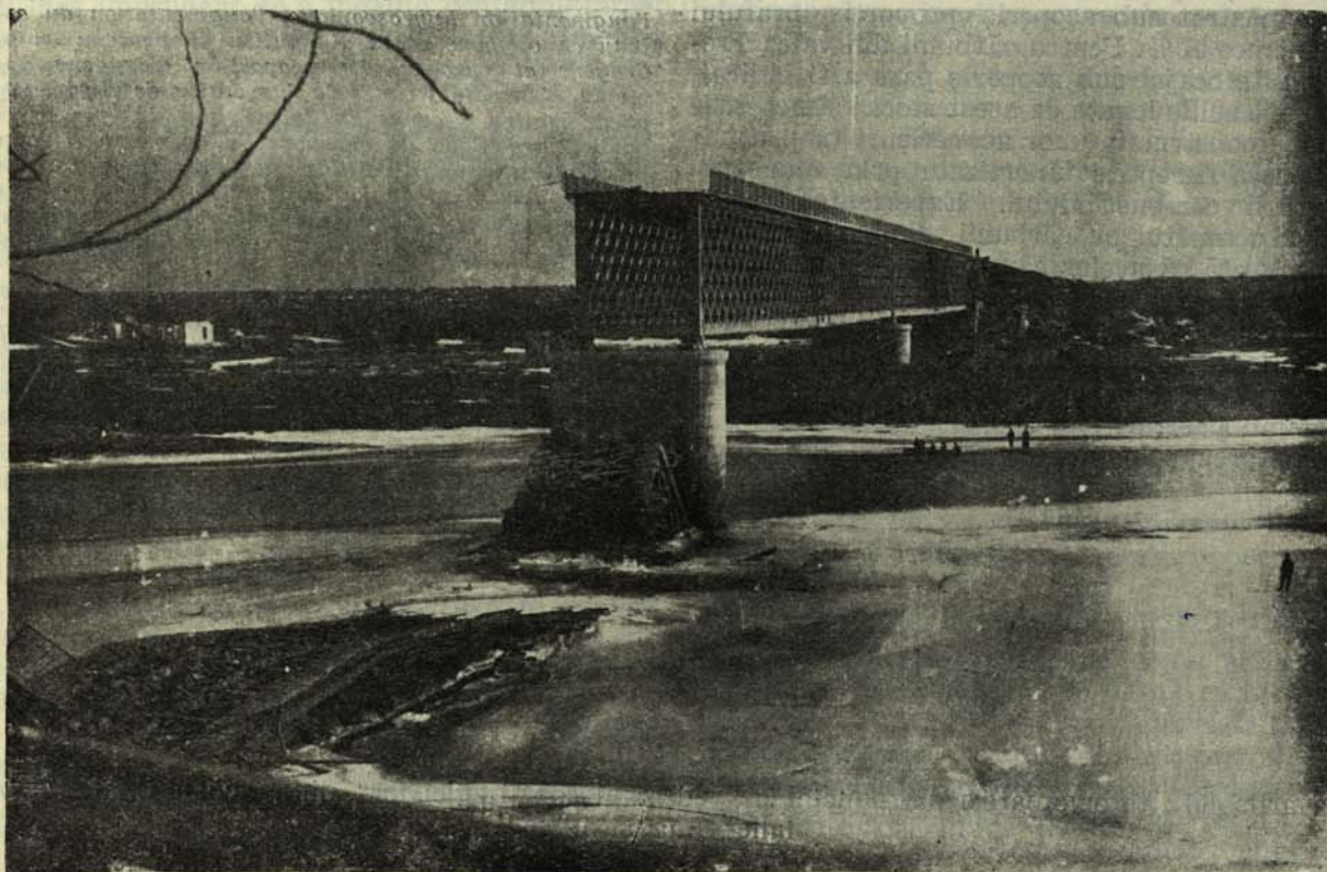
Fig. 1. — Vederea podului de peste Nistru înainte de restaurare.
