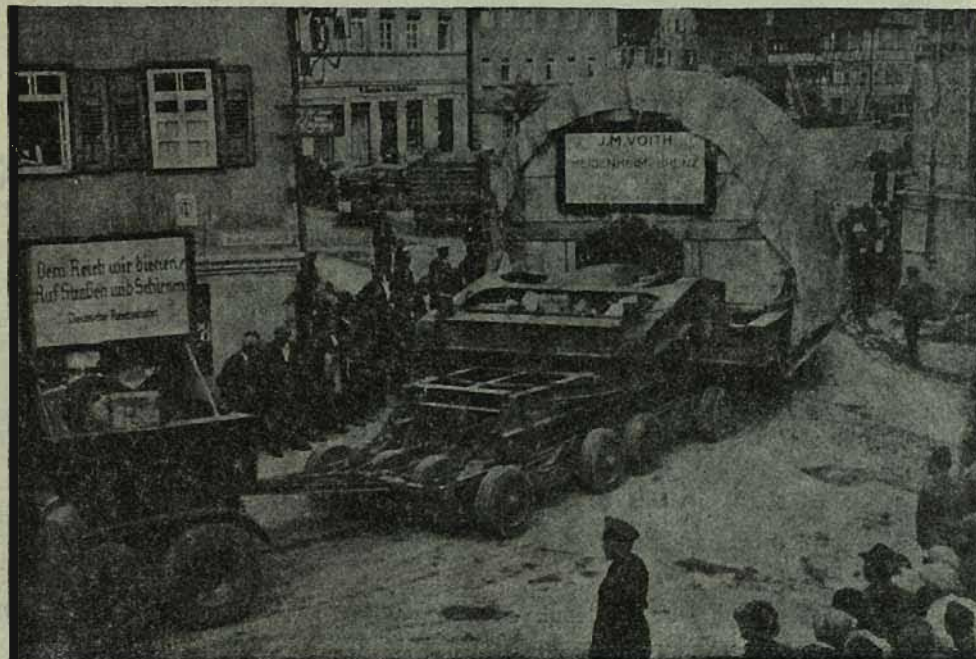
Transportul unui cilindru de 38,5 tone și \phi=4,5 m pe o distanță de 150 km, pe 2 vehicule de șosea unite prin grinzi intermediare
